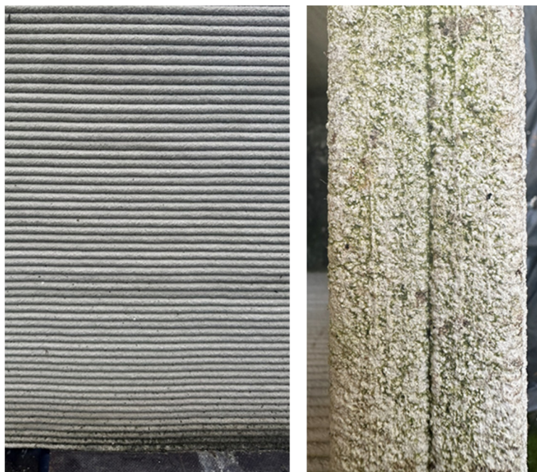
Obr. 2-22: Zasažení svislého povrchu biologickými činiteli (vlevo), detail horního povrchu dvojité stěny (vpravo).
